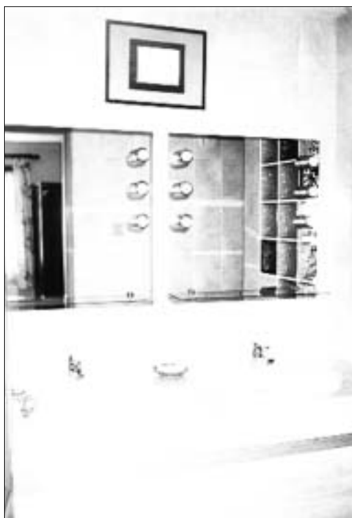
Ryc. 18. W przypadku, gdy w obiekcie urządzono wspólną łazienkę dla kilku rodzin, dobrym rozwiązaniem jest zamontowanie większej liczby umywalk. Obudowa umywalki w formie lamy daje większą powierzchnię użytkową, a jednocześnie kryje wszystkie rury instalacyjne
