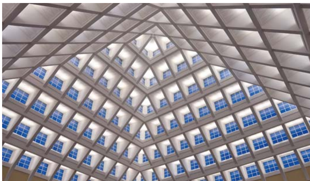
Realizacja auli SGH – wykonawca firma Dorbud Produkcja Sp. z o.o. / SGH Hall project – contractor: Dorbud Produkcja Sp. z o.o.
