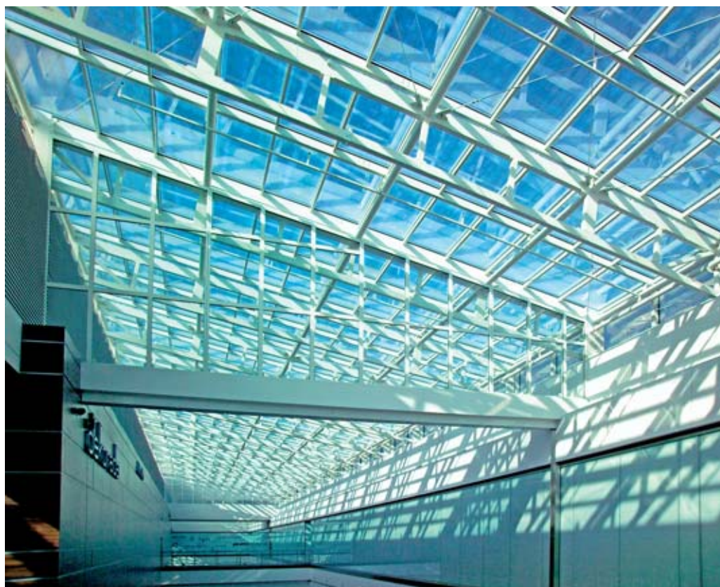
Świetliki szklane system SCHUECO pow. 6000 m 2 GALERIA ECHO Kielce 2011 – producent firma Aluto System Sp. z o.o. / Glass skylights, SCHUECO system, area of 6000 m 2 , GALERIA ECHO Kielce 2011 – manufacturer Aluto System Sp. z o.o.
